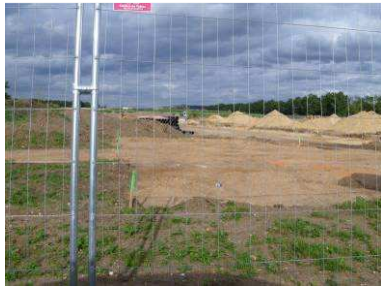
Aménagement de l'aire des gens du voyage en cours
