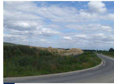
Remblais – route vers la Cité de Fromainville
