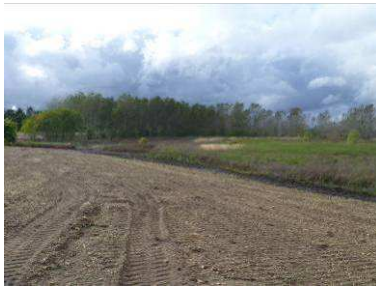
Zone de remblais
