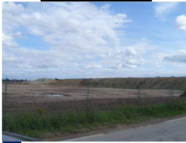
Terrassements et remblais
