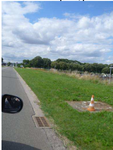
Accotement de voirie
